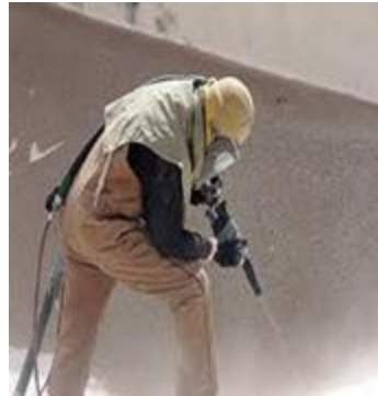
تصویر شماره ۵۱: عملیات سندبلاستینگ
